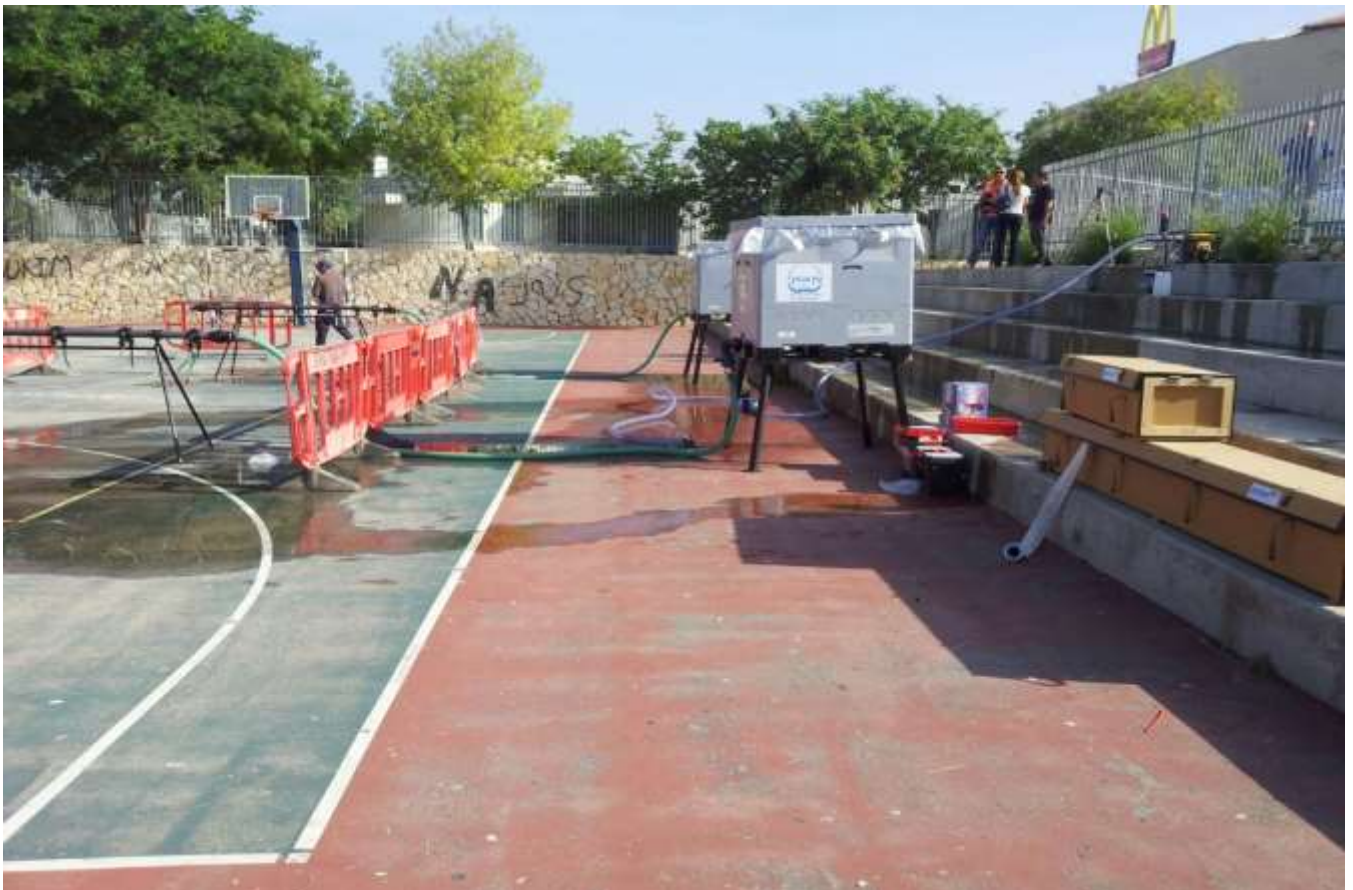
מיכל 1 קוב מסוג 'קומבו' (1,000 ליטר) עם ברזיות לחלוקת מים בתחנת חלוקה.
